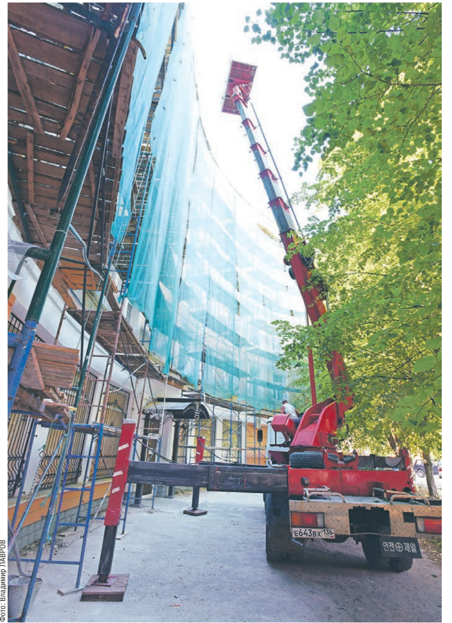
После внедрения бережливых технологий в работу ФКР взаимодействие с жильцами и подрядчиками вышло на новый, более высокий уровень
